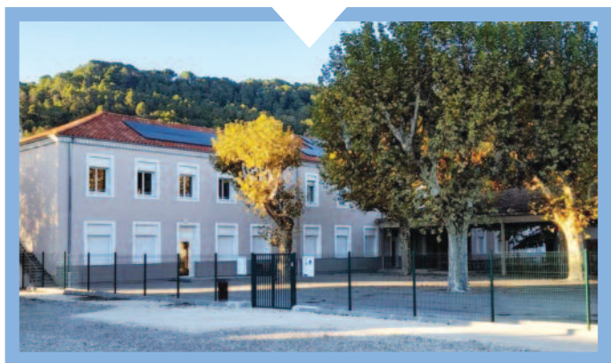
L'école du Centre réhabilitée
