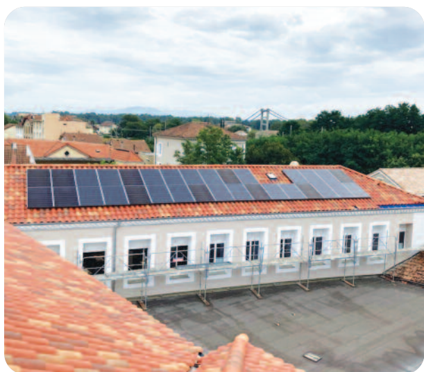
Installation de panneaux photovoltaïques sur le toit de l'école du Centre
