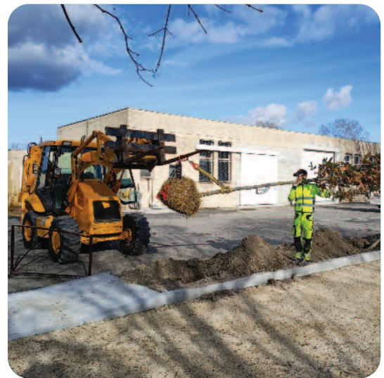
La rénovation des services techniques municipaux
