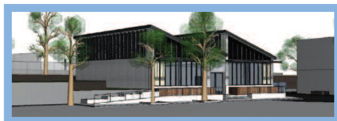
Bâtiment du futur "Utile" sur le place Pierre Sémard
