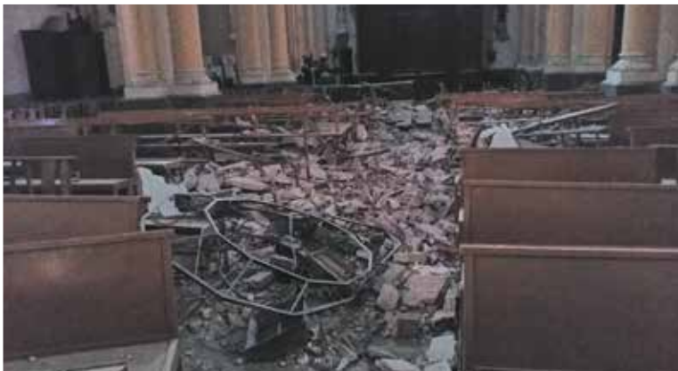
Intérieur de l'église du Centre - Novembre 2019.
