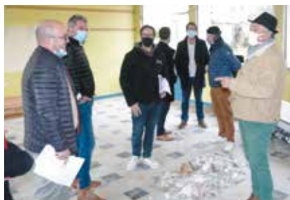
Visite du chantier de l'école – 11 février 2021
