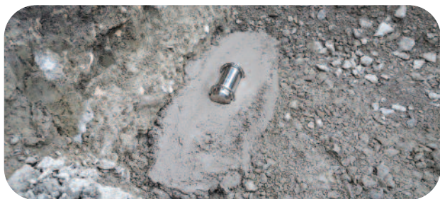
Capsule temporelle déposée dans les fondations
