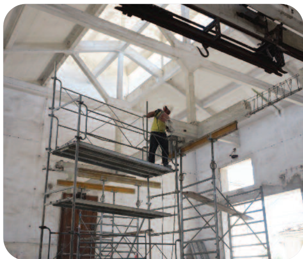
Chantier de la future salle de musique - Mai 2026
