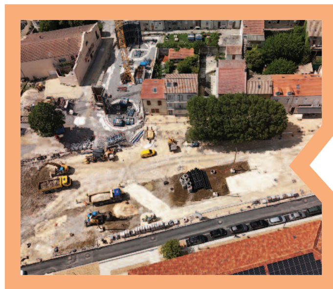
Chantier de l'église - Mai 2026
