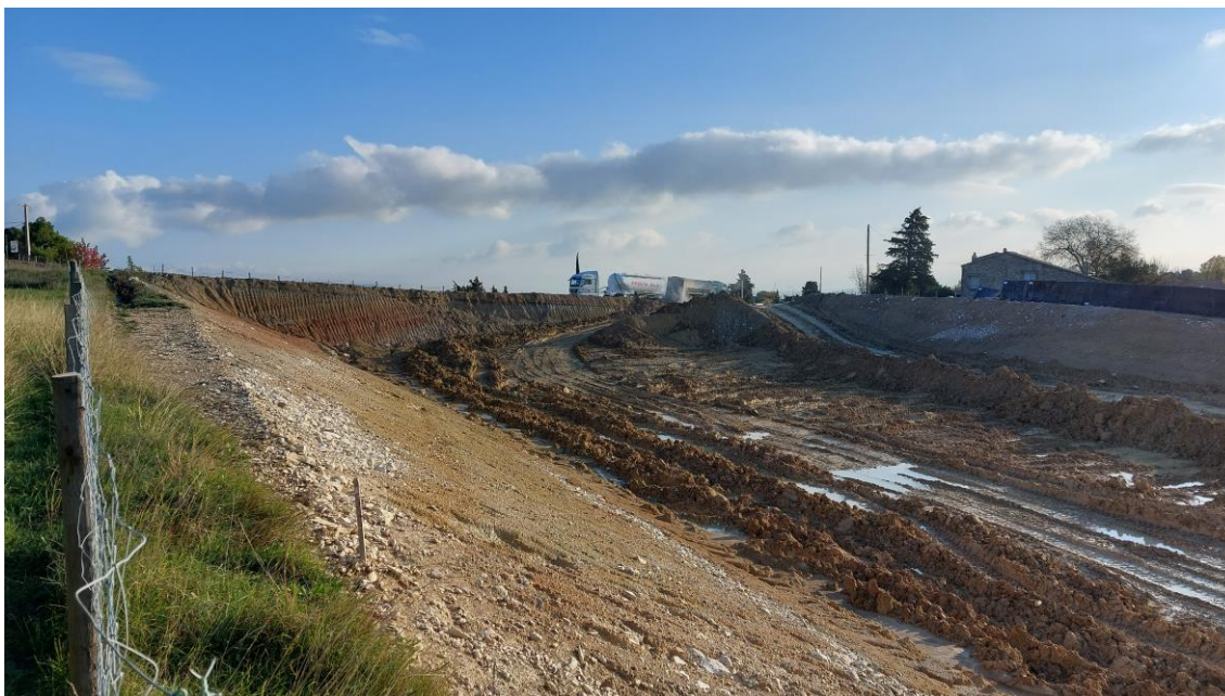
Le chantier RN 102 au droit du giratoire, décembre 2022
