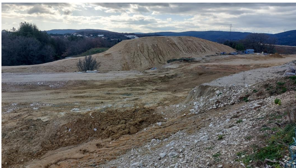
Emprise sud projet en janvier 2023
