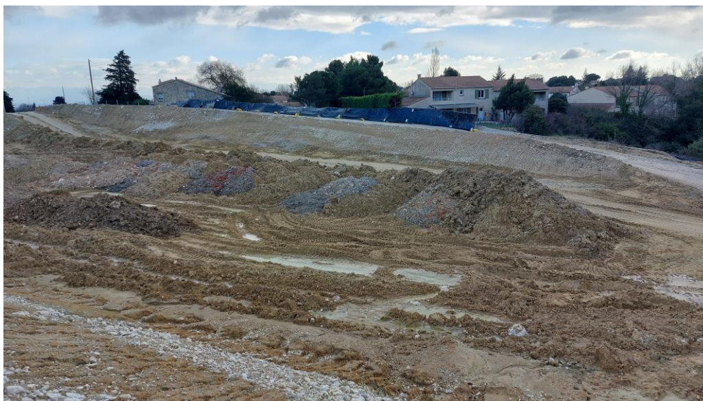
Emprise nord projet en janvier 2023
