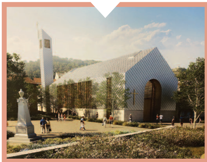
N°2 : matériau principal de couverture : le zinc
