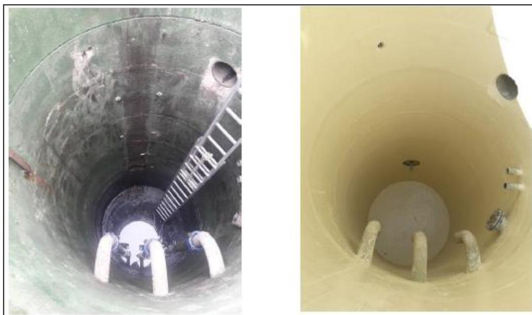
**Cuve du PR entrée STEP avant/après reprise de l'étanchéité (SAUR - RAD assainissement 2019)**
