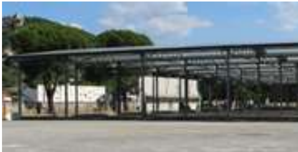
Allée Paul Avon, terrain de pétanque et parking
