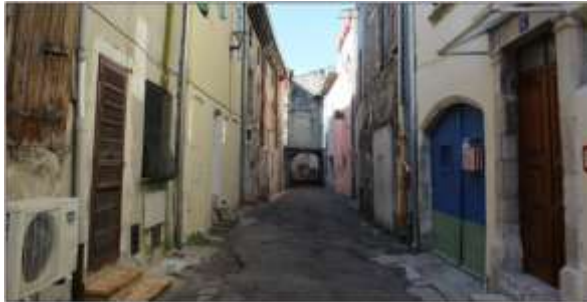
Voie tertiaire : rue Kleber
