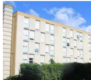
Immeuble collectif, rue du 19 Mars 1962.
