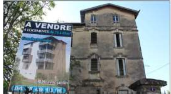
Maison bourgeoise rue Vincent Touchet réhabilitée en immeuble collectif
