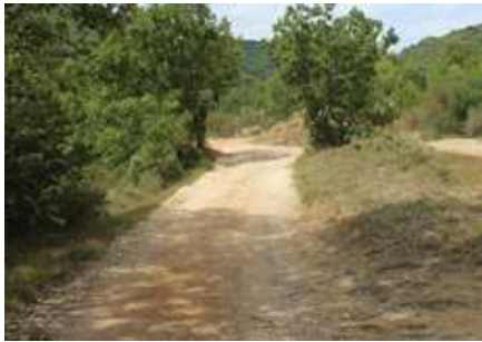
Voie tertiaire : chemin lieu-dit Estagnol.
