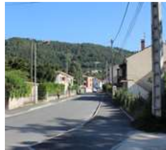
Voie secondaire : rue Vincent Touchet
