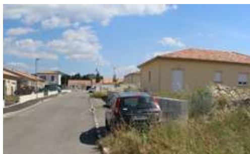
Opération de logements sociaux individuels et mitoyens – source : IATE
