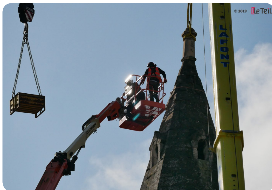
Dépose du clocher de l'église endommagé par le séisme © Mairie du Teil
