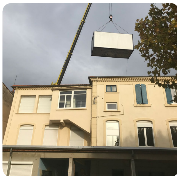
Installation d'un algéco suite au séisme © Mairie du Teil
